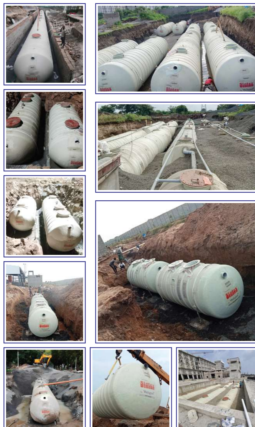
Actual site installation images.
